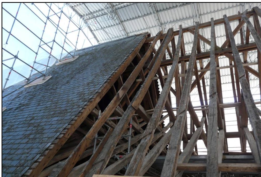
Charpente et toiture de la cathédrale de Bourges en cours de restauration
